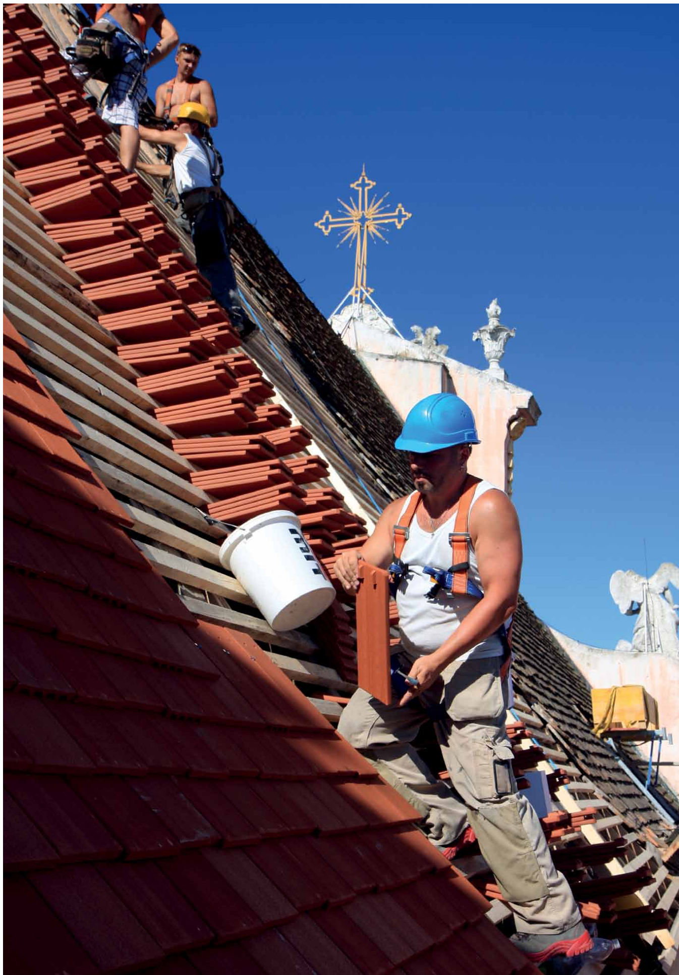
Abb. 43 Stift Göttweig, Renovierung des Kirchendaches
