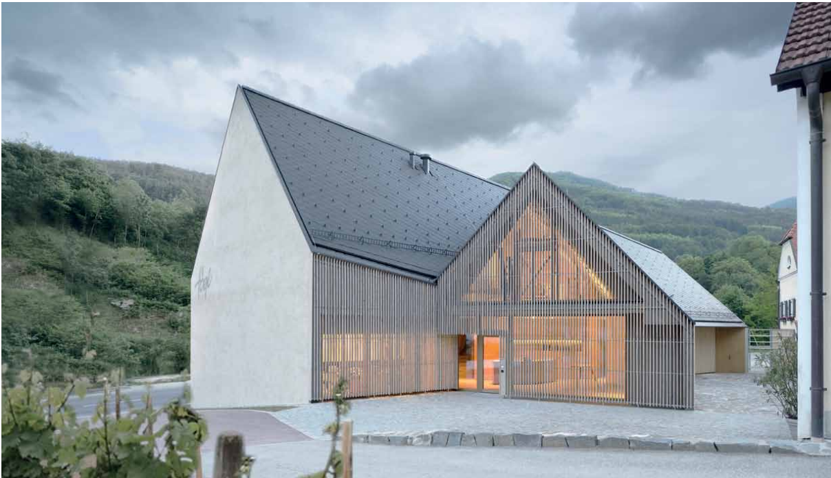
Abb. 44 Weingut Högl. Mit dem Staatspreis Architektur 2016 ausgezeichnete Neubau für Produktion und Verkostung
